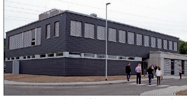
Das Verwaltungsgebäude des Abfallzweckverbandes: Die Geschäftsstelle ist kürzlich von der Koblenzer Rizzastraße in das neu errichtete Verwaltungsgebäude auf dem Deponiegelände umgezogen.
